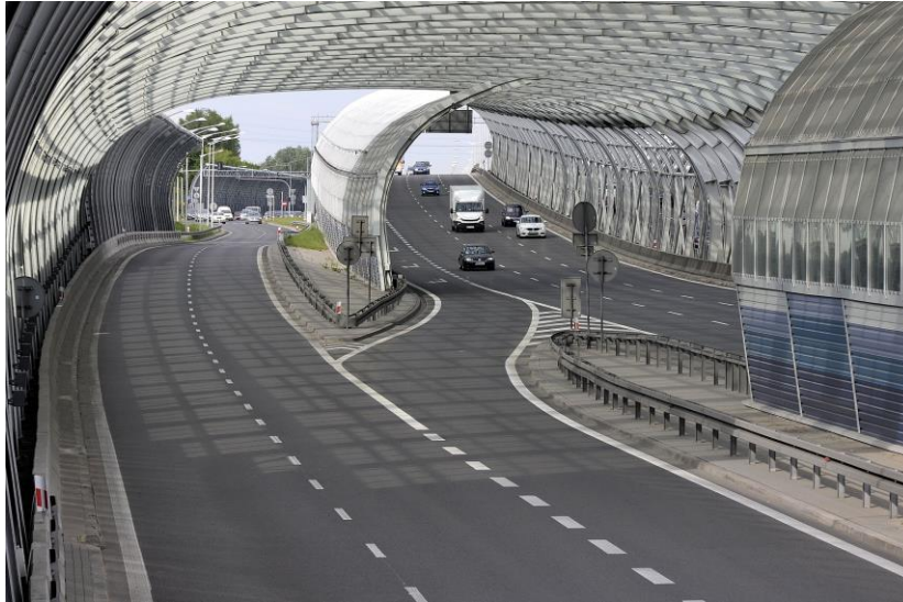
Rysunek 16. Nowoczesny ekran akustyczny na Trasie Toruńskiej w Warszawie.
