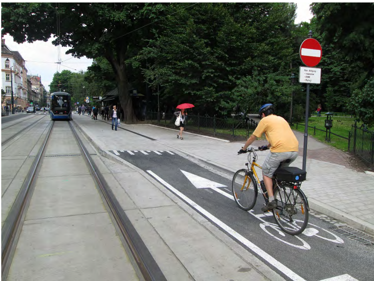
Fot. 4. „Przystanek wiedeński” zlokalizowany w przedłużeniu pasa ruchu dla rowerów (kontrapasa). Ze względu na wspólny ruch tramwajów i autobusów zastosowano krawężnik typu „kassel” umożliwiający bezpieczny dojazd autobusu do krawędzi. Kraków, ul. Podwale.
