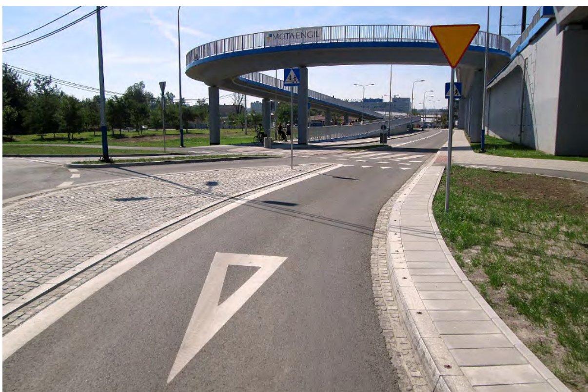
Fot. 14. Poprawne oznakowanie przejazdu dla rowerzystów przecinającego łącznicę („bypass”). Za znakiem poziomym P-15 i pionowym A-7 widać znak D-6b który nie ustala pierwszeństwa i jest jedynie znakiem informacyjnym. Przed przejazdem dla rowerzystów wyznaczono linię zatrzymań złożoną z trójkątów (P-13). Kraków, ul. Saska.
