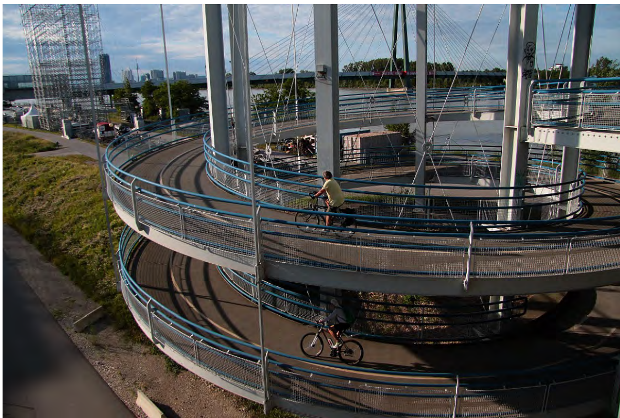
Fot. 15. Pochylnia ślimakowa prowadząca z brzegu Dunaju na drogę dla rowerów zlokalizowaną w dolnym poziomie mostu Praterbrücke. Widoczna prawidłowa orientacja pochylni: w lewo w dół, zapewniająca większy promień łuku rowerzystom jadącym z większą szybkością w dół i minimalizująca ryzyko kolizji. Zwraca uwagę wysoka balustrada z wybaczną poręczą. Wiedeń, Austria.
