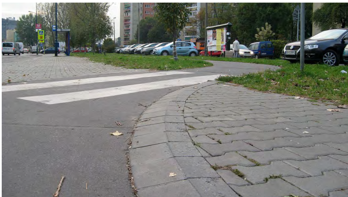
Fot. 5. Prawidłowe oddzielenie drogi dla rowerów od przylegającego chodnika położonym na płasko krawężnikiem drogowym (wjazdowym), tworzącym skos ok. 15-30 stopni przy
