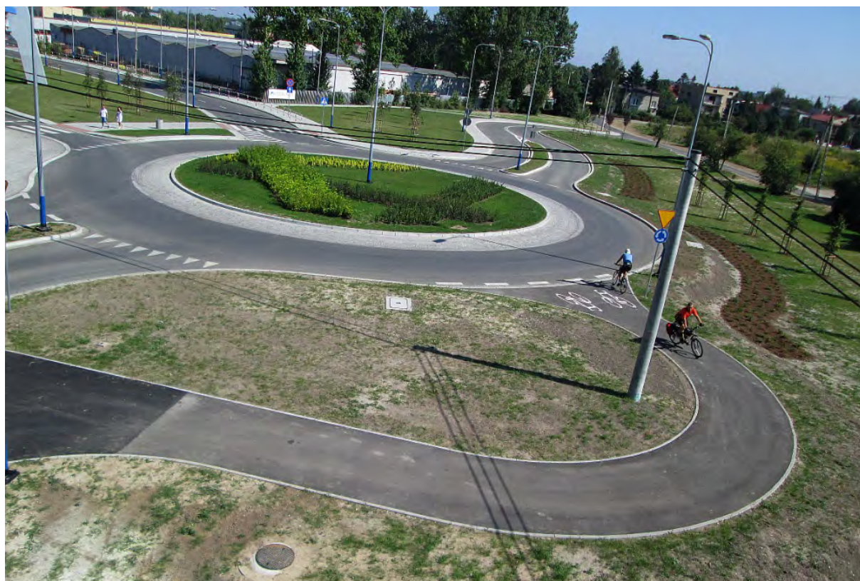
Fot. 12. Droga dla rowerów jako samodzielny wlot małego ronda. Skrzyżowanie ulic Saskiej i Żołnierskiej, Kraków.
