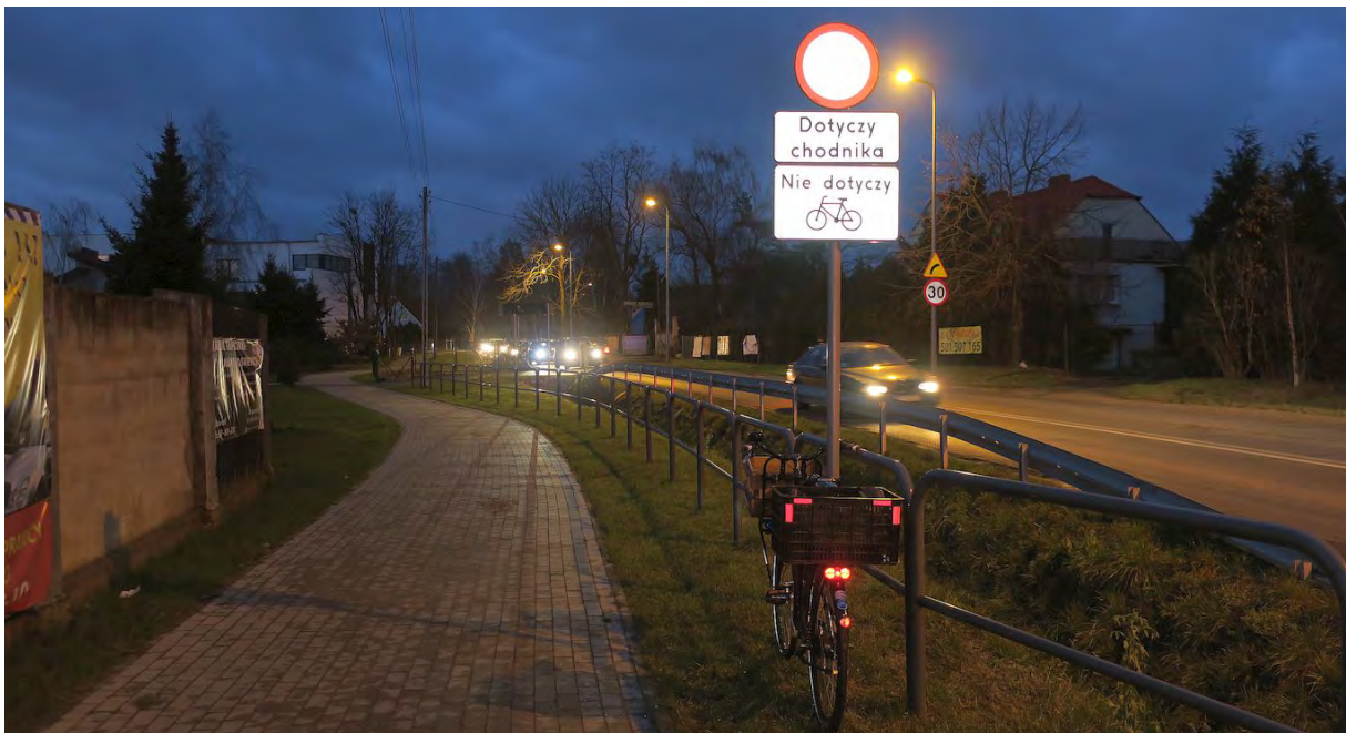
Fot. 7. Dopuszczenie ruchu rowerów na substandardowej drodze pieszej. Rowerzysta nie ma obowiązku korzystać z tak oznaczonej drogi. Poznań, ul. Morasko.
