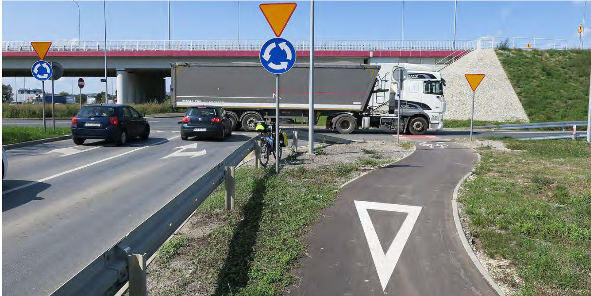
Fot. 11. Poprawne oznakowanie przejazdu dla rowerzystów przez wylot ronda turbinowego. Pojazdy opuszczające dwoma pasami ruchu rondo nie skręcają w drogę poprzeczną i zachodzi konieczność ustalenia pierwszeństwa na przejeździe znakami drogowymi. Węzeł „Rybitwy”, droga ekspresowa S-7, Kraków.
