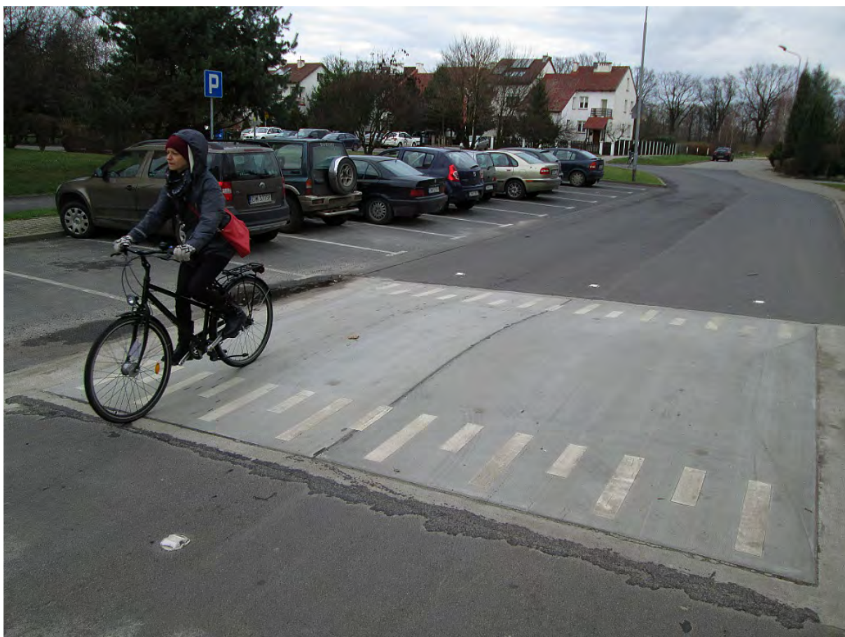
Fot. 1: Prefabrykowany płytowy próg zwalniający, optymalny z punktu widzenia ruchu rowerowego ze względu na obniżenia przy krawędzi jezdni (Wrocław).
