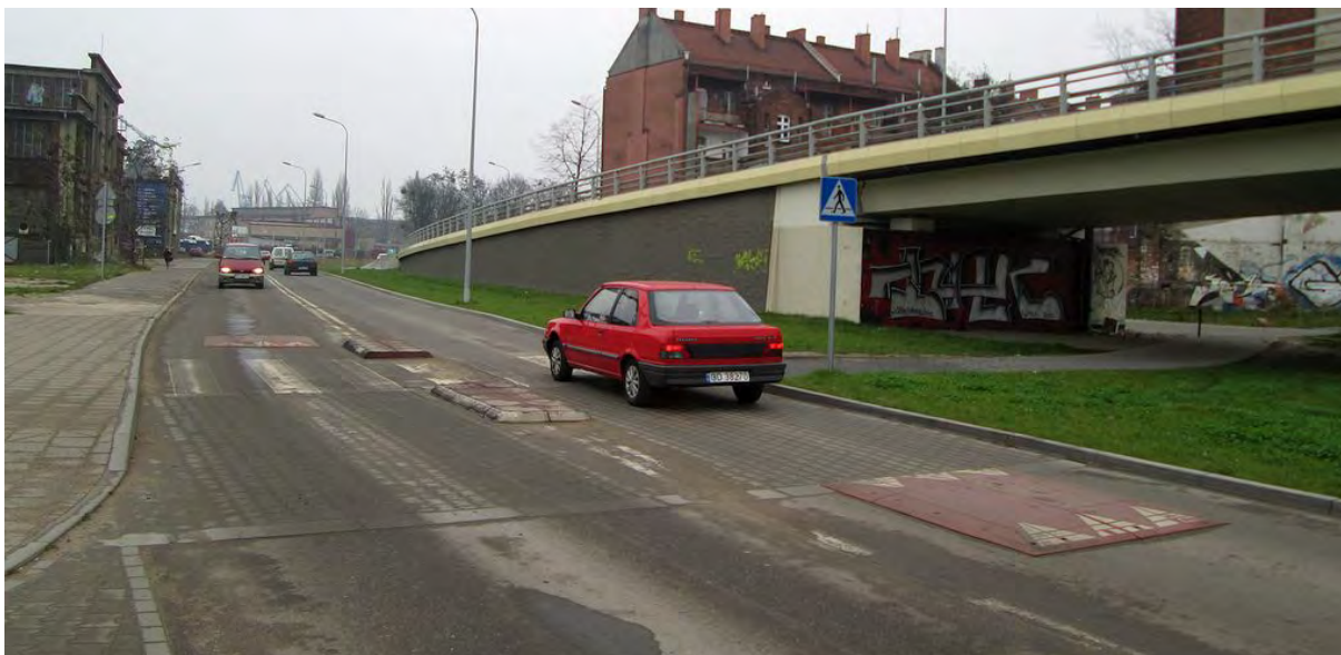
Fot. 2. Przykład uspokojenia ruchu przy pomocy prawidłowo umieszczonych progów wyspowych uzupełnionych wyspą dzielącą. Niemożliwe jest ominięcie progów. Gdańsk, ul. Narzędziowców.
