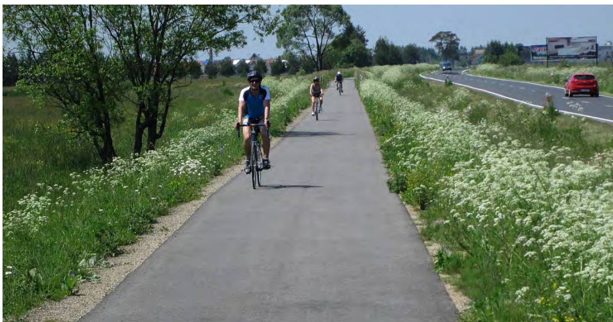
Fot. 6. Droga dla rowerów o nawierzchni asfaltowej wykonana na poszerzonej podbudowie, bez zbędnych i podnoszących koszty obrzeży lub krawężników. Droga wojewódzka nr 957, fragment trasy rowerowej euroregionu Tatry Nowy Targ – Sucha Hora/Trstena (Słowacja).
