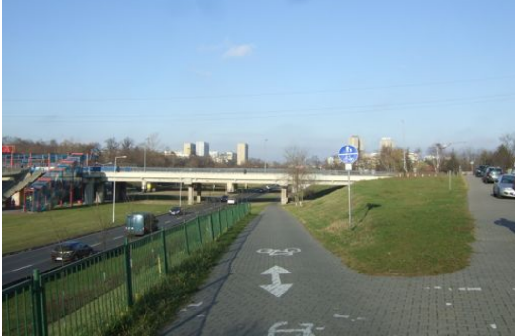
Ulica Księcia Mieszka I, jedna z ważniejszych relacji rowerowych w mieście, droga dla pieszych i rowerów poprowadzona wzdłuż jezdni przy każdym skrzyżowaniu stwarza dla rowerzysty utrudnienie w postaci konieczności pokonania przewyższenia, ponadto niewłaściwa i zniszczona nawierzchnia również utrudnia jazdę.
