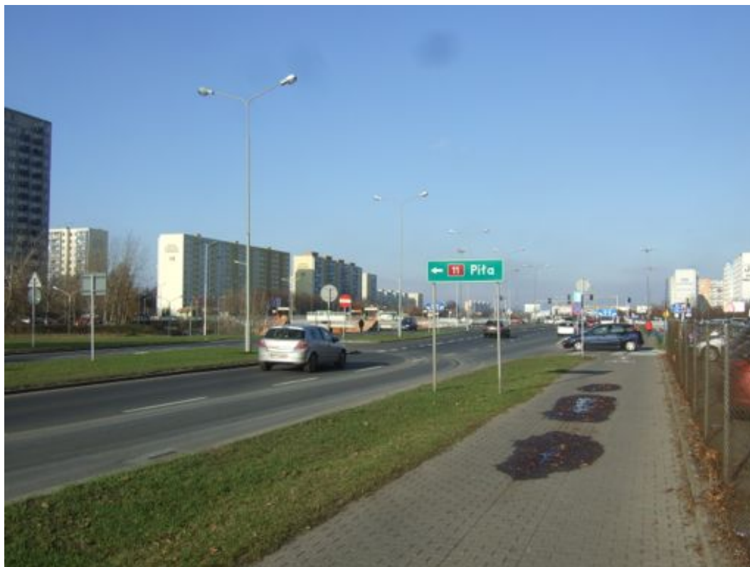
Ulica Szeligowskiego, droga dla pieszych i rowerów, nawierzchnia z fazowanej kostki brukowej, miejscami pozapadanej nie zachęca do podróży wzdłuż linii Poznańskiego Szybkiego Tramwaju.
