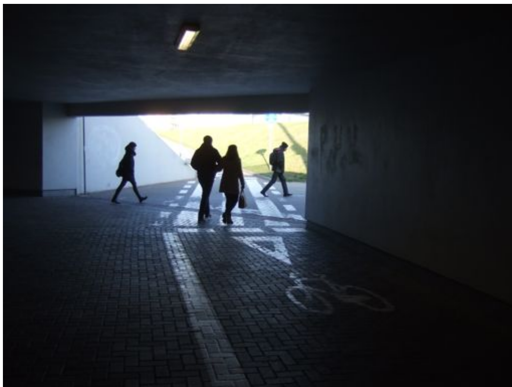
Ulica Szeligowskiego, niebezpieczny wyjazd z tunelu, w tym miejscu brakuje lustra.
