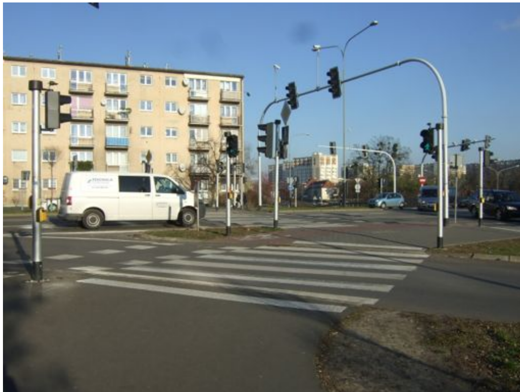
Ulica Wojska Polskiego (skrzyżowanie z ul. Wincentego Witosa), przejazd rowerem przez to skrzyżowanie generuje uciążliwe opóźnienia. Na zdjęciu widać przynajmniej dziewięć przycisków do wzbudzenia zielonej fazy dla rowerzysty i pieszego! Niezgodne z obowiązującym w Polsce prawem przyciski są niestety stosowane na wielu poznańskich skrzyżowaniach.
