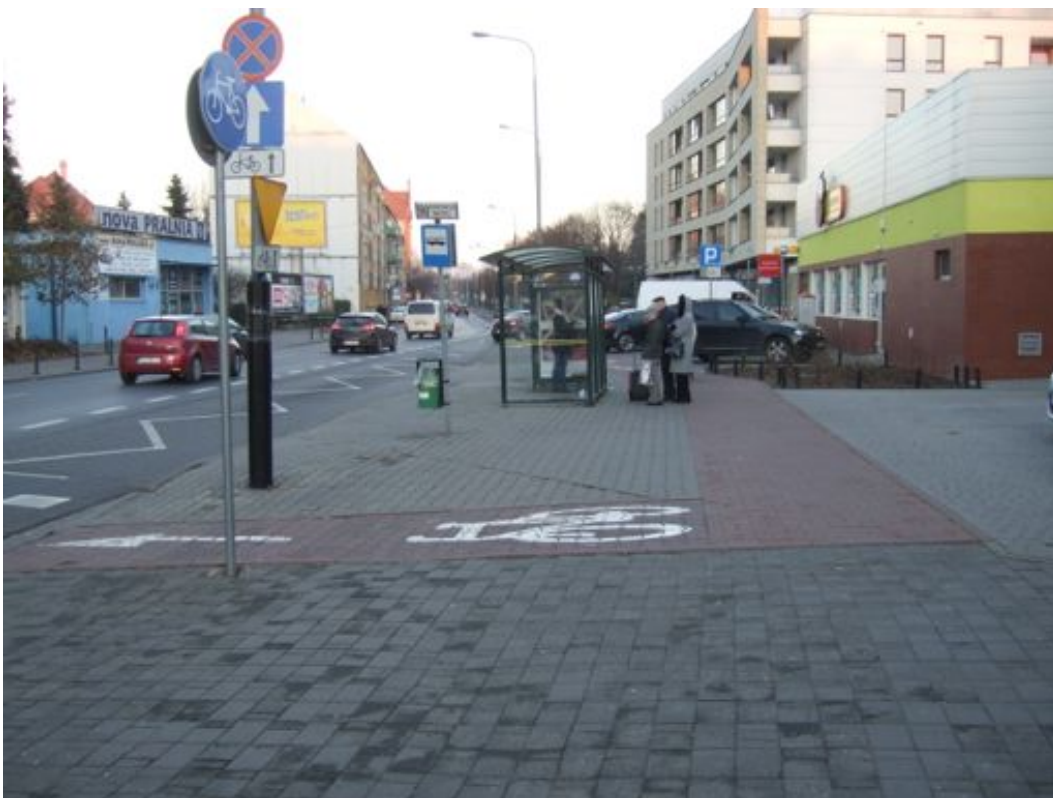
Ulica Kazimierza Wielkiego, organizacja ruchu rowerowego ma tu charakter unikatowy i osobliwy: rowerzyści poruszają się tu względem siebie jak w ruchu lewostronnym, w jedną stronę jadą po pasie rowerowym w jezdni, a w przeciwnym (z Mostu Rocha) na prawo od jezdni. Zakończenie drogi dla rowerów po południowej stronie zakrętem pod kątem 90 stopni nie wymaga komentarza.
