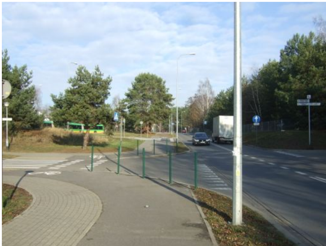
Ulica Dziegiełowa, przykład rozwiązania, gdzie płynności jazdy samochodów uzyskana została kosztem płynności i bezpieczeństwa ruchu rowerowego. Na pozór dobrej jakości dwukierunkowa droga dla rowerów bardzo spowalnia rowerzystów, przejazdy na skrzyżowaniach wykonano tu niezgodnie z dobrą praktyką. Widoczne odgięcie na przejeździe przez drogę podporządkowaną utrudnia też wzajemną widoczność i może być przyczyną wypadków.
