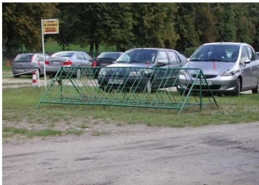
RYS. 40. Nieprawidłowa konstrukcja stojaka rowerowego – brak możliwości zabezpieczenia koła i ramy roweru
