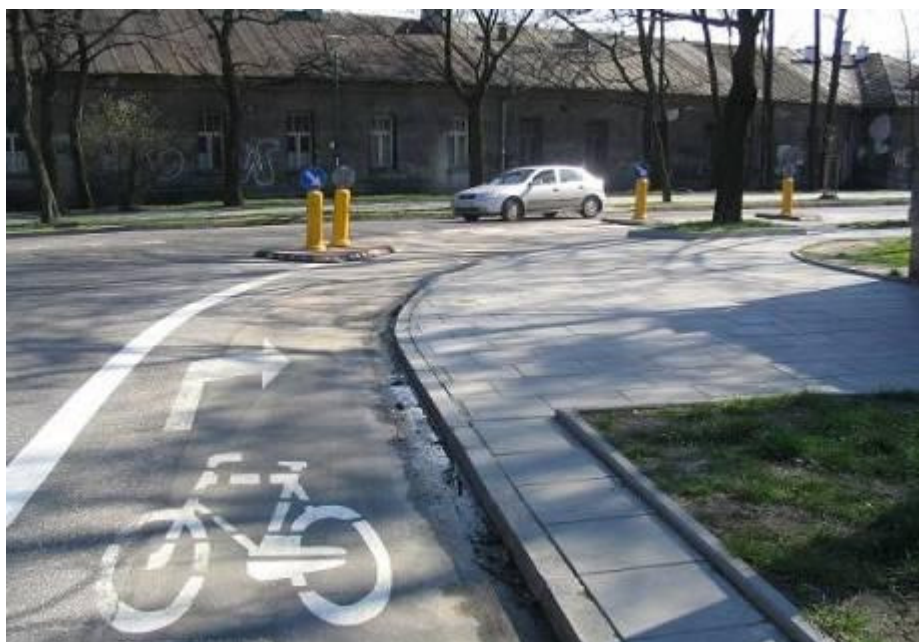
RYS. 5. Kontrapas rowerowy w rejonie łuku poziomego – wysepki dzielące zabezpieczają rowerzystów przed ścinającymi zakręt samochodami
