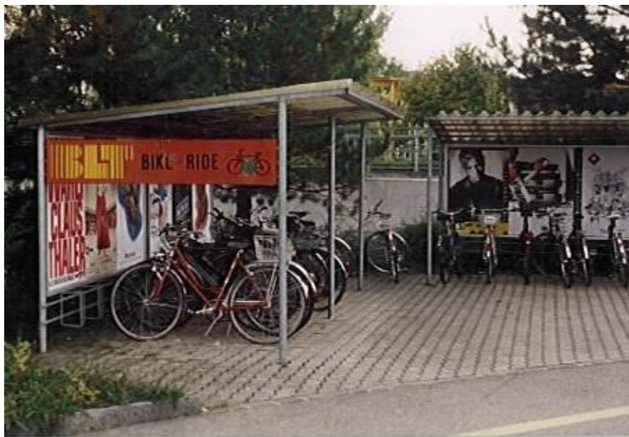
RYS. 31. Najprostszy węzeł integracyjny w postaci stojaka przykrytego wiatą (takich stojaków nie należy stosować!)
