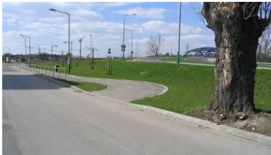
Rys. 15. Nieprawidłowo wykonany wjazd na drogę rowerową
