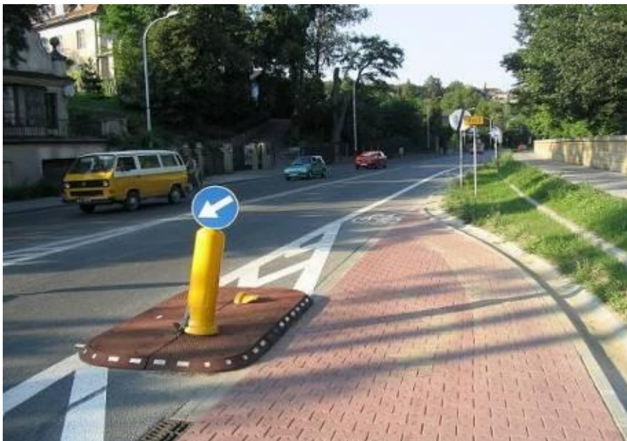
RYS. 16. Prawidłowo wykonany wyjazd z drogi rowerowej na drogę ogólnodostępną, ale niewłaściwa nawierzchnia
