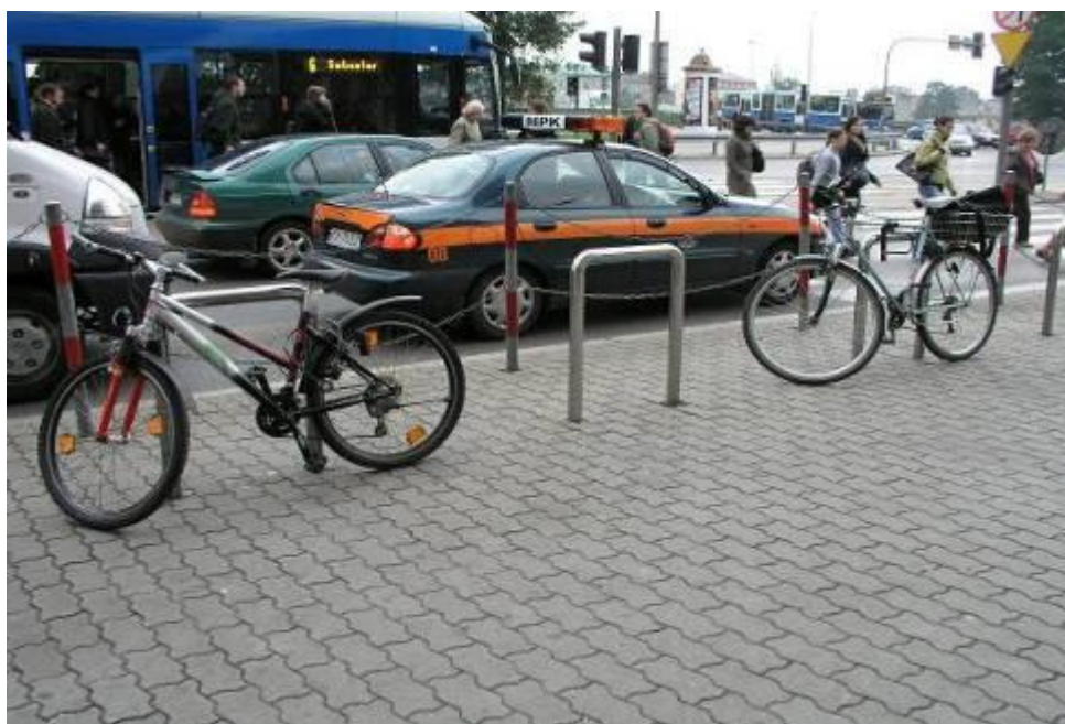
RYS.42. Rekomendowany typ stojaka rowerowego – Możliwość zabezpieczenia ramy i kół roweru
