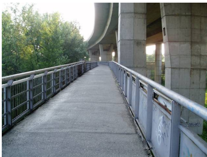
Fotografia 50. Bratysława, droga dla rowerów na estakadzie przy Pristawnym Moście
