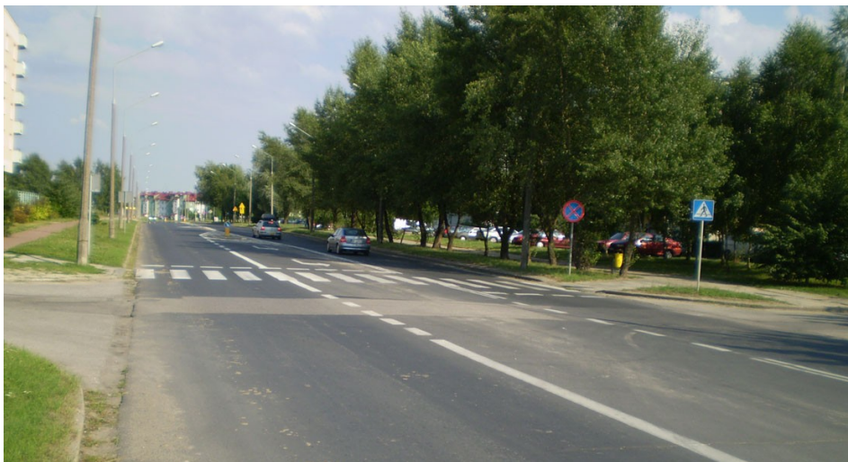
Fotografia 53. Obecny przekrój al. Armii Krajowej, wynoszący niemal 14 m można z powodzeniem podzielić na 3 pasy ruchu samochodowego oraz 2 pasy dla rowerów
