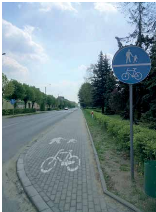
Fot. 2. Ciąg pieszo-rowerowy przy DW 901 w m. Zawadzkie
