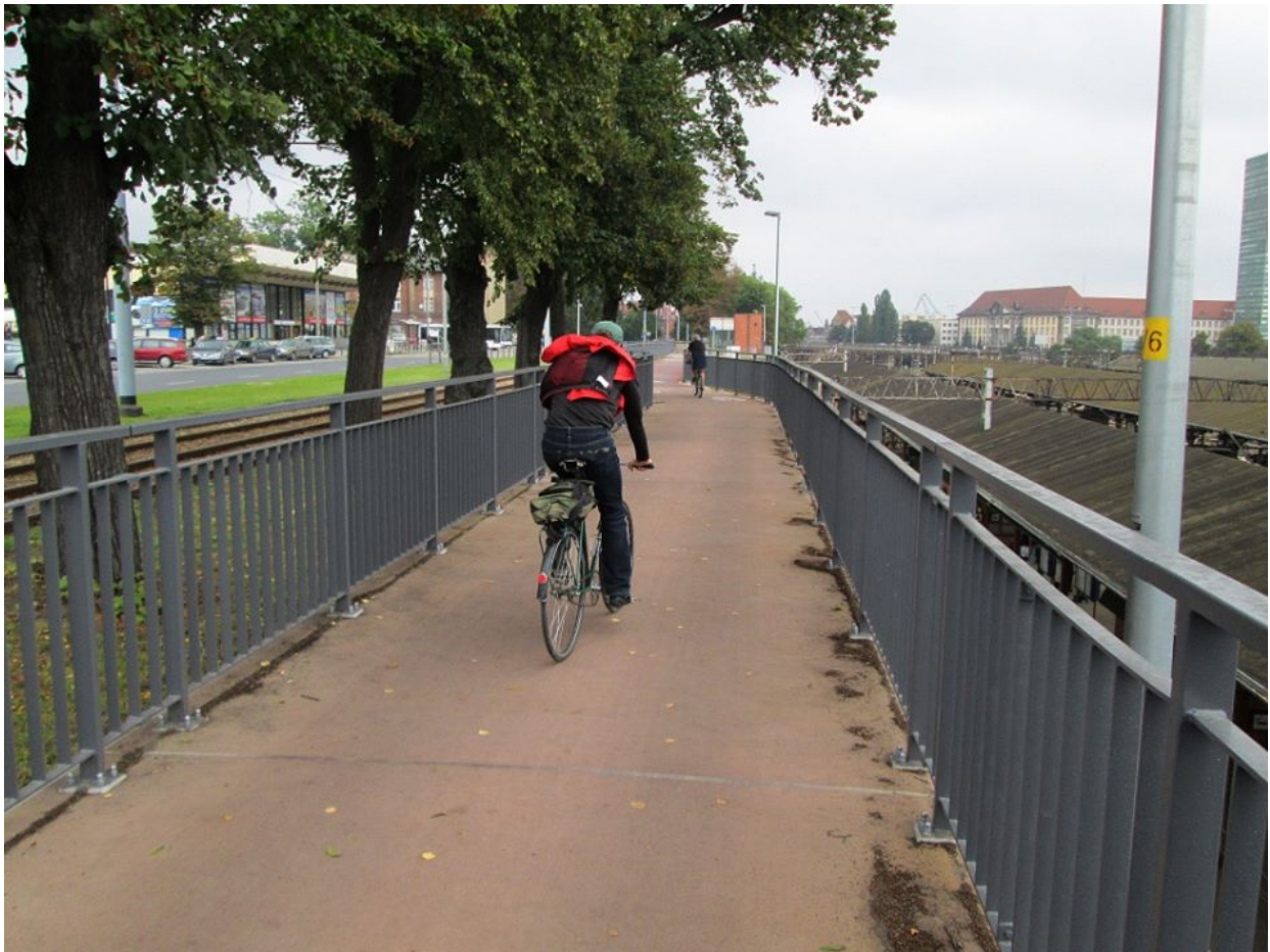
Ilustracja 6: Kładka stokowa w Gdańsku nad stacją kolejową.
