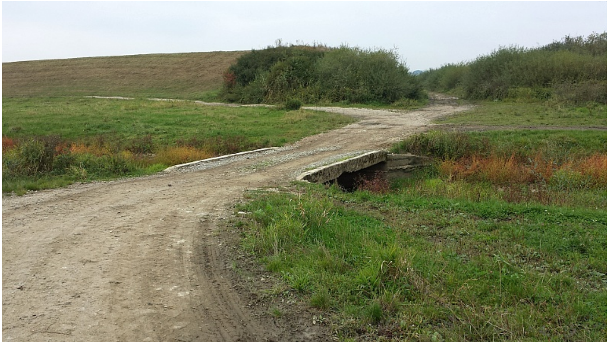
Ilustracja 9: Przykład kładki niskowodnej nad potokiem Kisielina.
