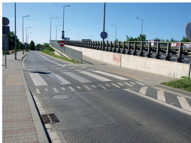
WROCLAW. Ulica Petuniowa, na której wyznaczono kontrapas (dolna jezdnia), drogę dla rowerów na wiadukcie oraz wyniesiony przejazd dla rowerów aby móc się tam bezpiecznie przedostać z drogi dla rowerów. Fot. Hubert Barański.
