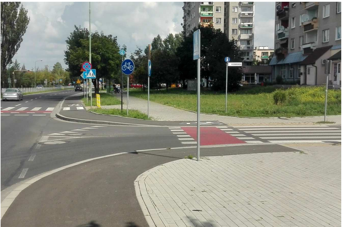
Fotografia 4 Odgięcie drogi dla rowerów przed samym przejazdem – ul. Sikorskiego
