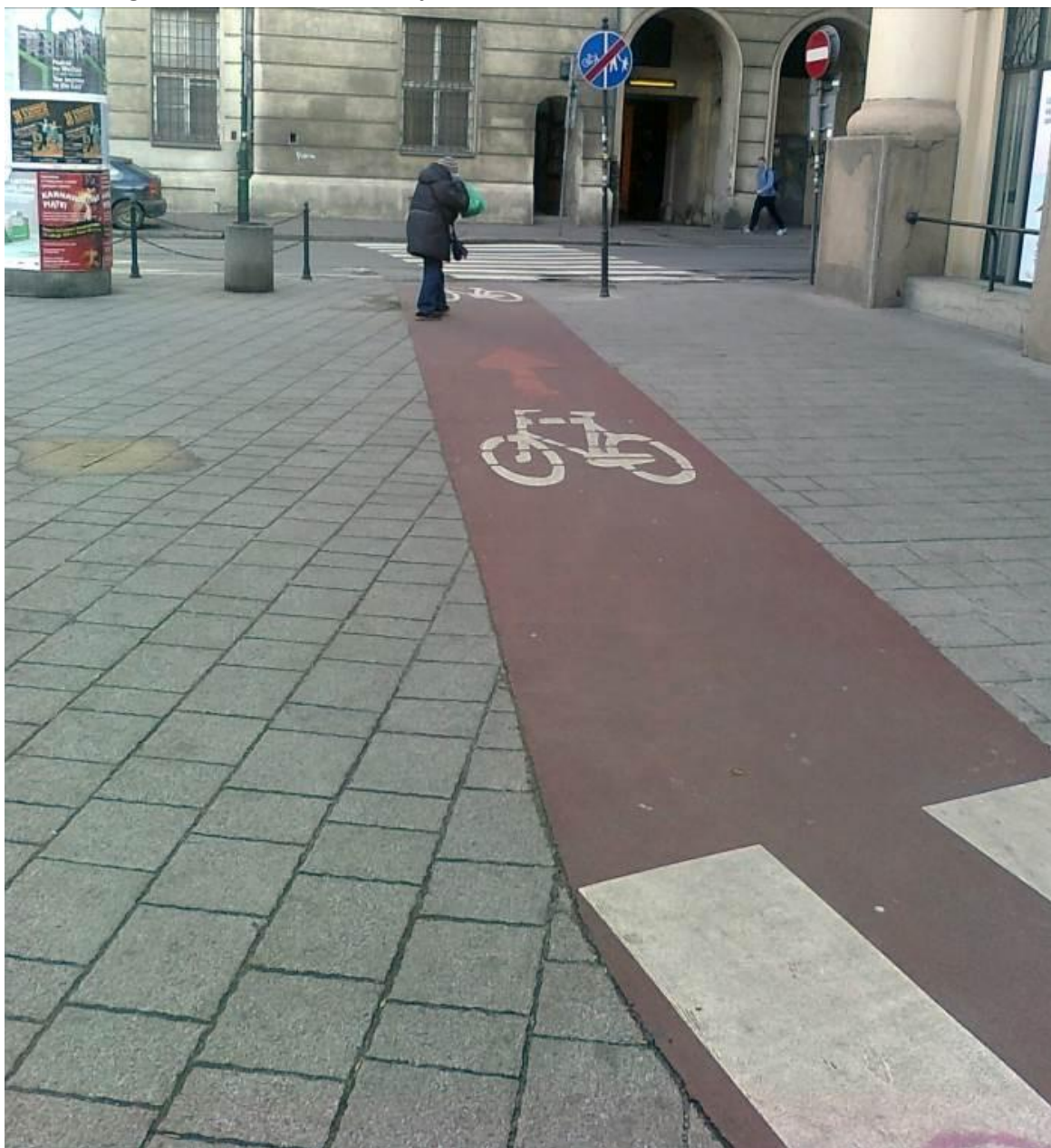
Rysunek 49. Przykład drogi rowerowej w mieście z pasem ruchu w jednym kierunku, wykonanej w technologii nawierzchni bitumicznej.
