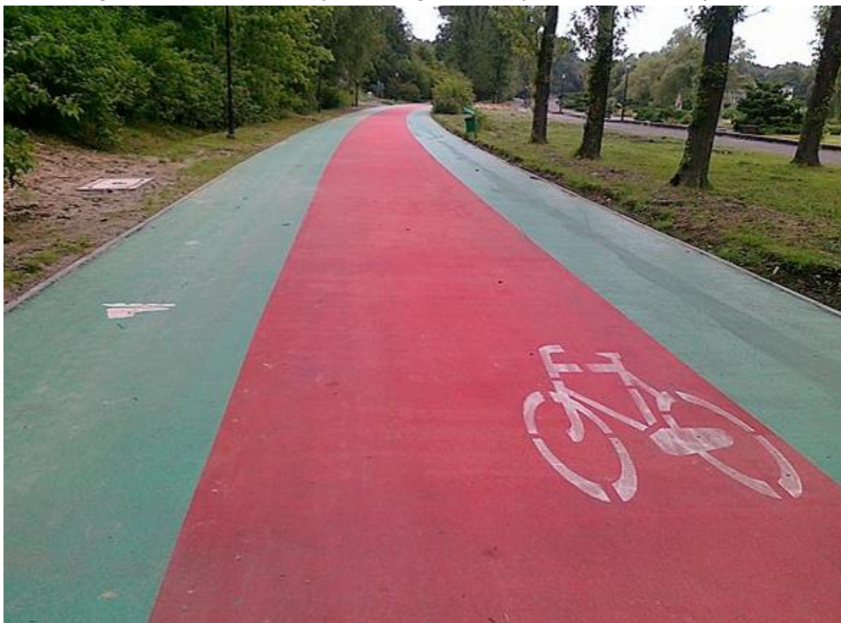
Rysunek 48. Przykład drogi rowerowej dwukierunkowej (szerokości 2,5 m) wykonanej w technologii nawierzchni bitumicznej (obok drogi rowerowej – ścieżka dla rolkarzy).
