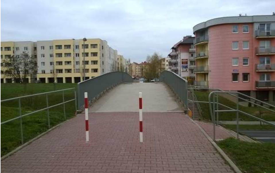
Rysunek 5 Kładka pieszo - rowerowa na osiedlu Dobrzec
