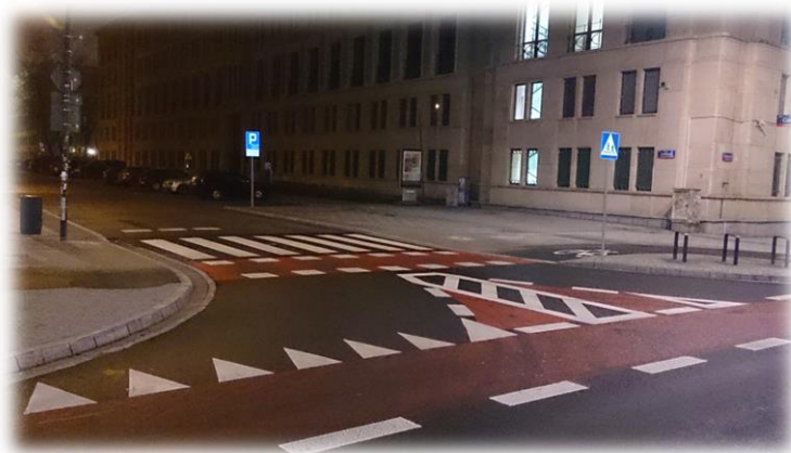
Ryc. 26. Foto.9. Przykład dobrze wykonanego przejazdu dla rowerzystów oraz śluzy rowerowej. Źródło: archiwum M&G
