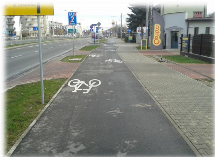
Ryc. 21. Foto.3. Przykład dobrze wykonanych zjazdów z jezdni przez ścieżkę rowerową do nieruchomości położonej przy drodze. Źródło: archiwum M&G
