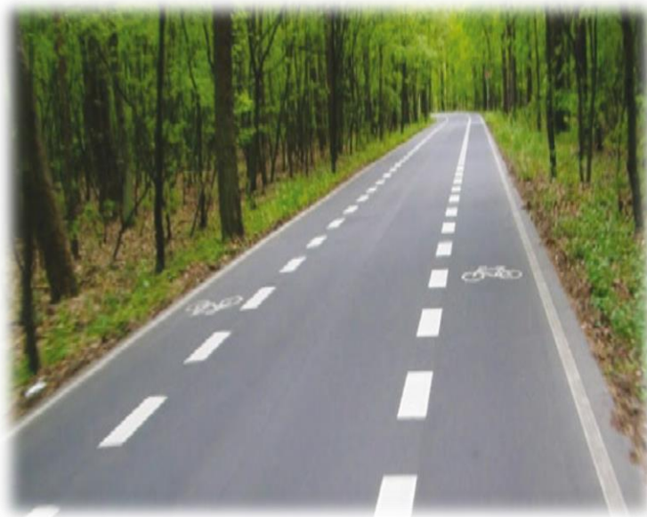
Ryc.96. Foto.69. Wydzielone pasy dla rowerów w terenie niezabudowanym (szer. pasa 1,5 m). Źródło: archiwum M&G.
