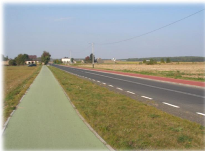
Ryc.92. Foto.65. Adaptacja pobocza, ścieżka rowerowa dwukierunkowa, nawierzchnia asfaltowa w terenie niezabudowanym. Źródło: archiwum M&G.
