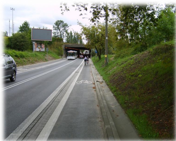
Ryc. 31. Foto.16. Przykład dobrze wykonanego przejazdu dla rowerzystów (ścieżka rowerowa jedno kierunkowa po obu stronach jezdni) w tunelu pod torami kolejowymi. Źródło: archiwum M&G
