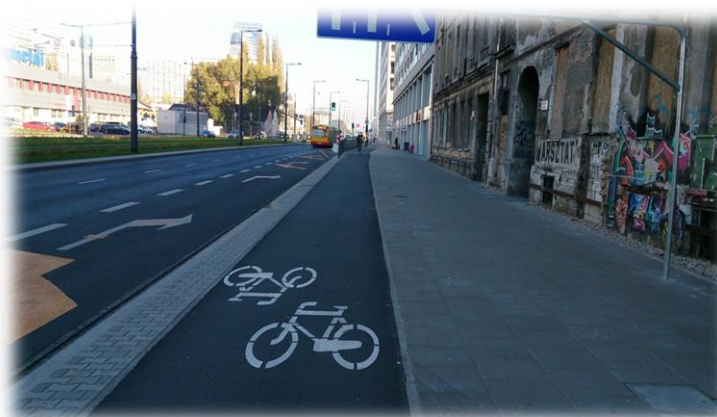
Ryc.86. Foto.59. Wydzielona ścieżka rowerowa dwukierunkowa, nawierzchnia asfaltowa w terenie zabudowanym.
