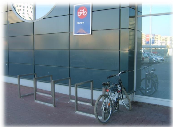
Ryc.73. Foto.29. Prawidłowa konstrukcja stojaków rowerowych. Źródło: archiwum M&G
