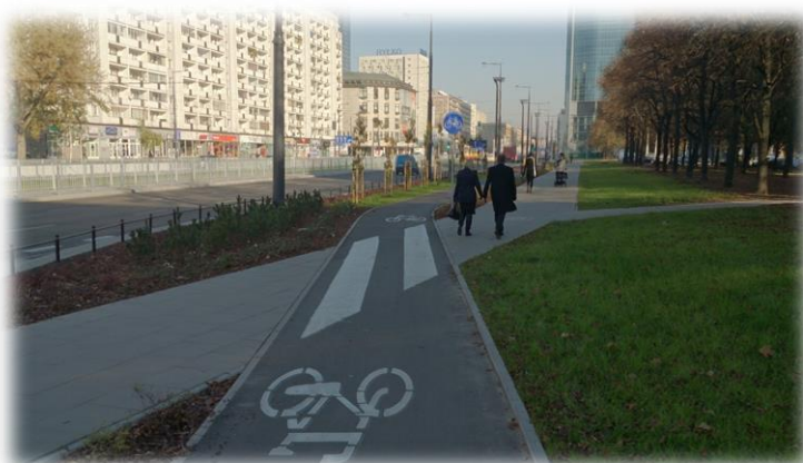
Ryc.88. Foto.61. Wydzielona ścieżka rowerowa dwukierunkowa (przejazd przez chodnik dla pieszych), nawierzchnia asfaltowa w terenie zabudowanym. Źródło: archiwum M&G.
