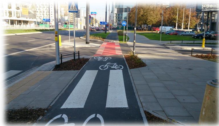
Ryc. 20. Foto.2. Przykład dobrze wykonanego przejazdu dla rowerzystów przez skrzyżowanie bez sygnalizacji świetlnej. Źródło: archiwum M&G
