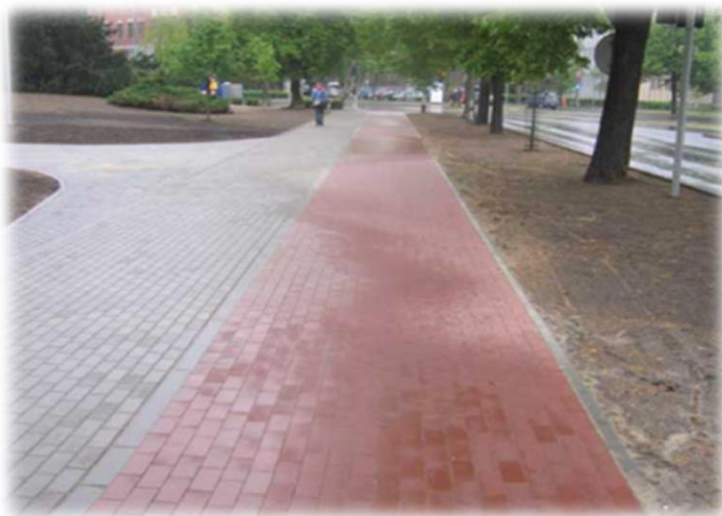
Ryc.87. Foto.60. Ciąg pieszo – rowerowy, nawierzchnia z kostki betonowej w terenie zabudowanym (warunki szczególne – teren zabytkowy uzgodnienia z Konserwatorem Zabytków. Źródło: archiwum M&G.
