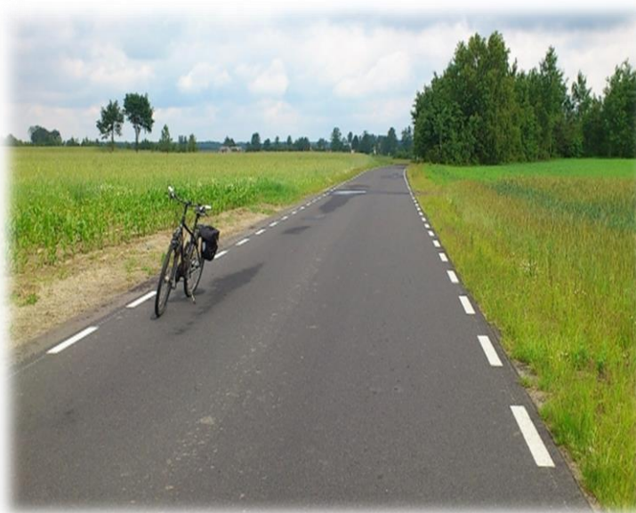
Foto.93. Ruch rowerowy na zasadach ogólnych, nawierzchnia asfaltowa w terenie niezabudowanym. Źródło: archiwum M&G.
