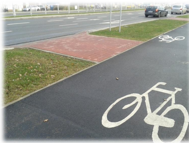
Ryc. 24. Foto.6. Przykład dobrze wykonanego (jezdni – ścieżka) zjazdu z jezdni przez ścieżkę rowerową. Źródło: archiwum M&G.
