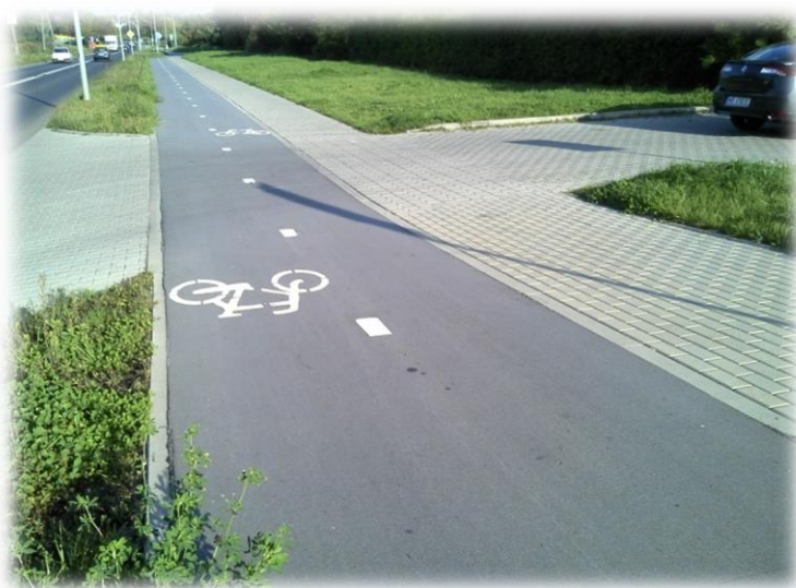
Ryc.69. Foto.26. Przykład wykonania dwukierunkowej drogi dla rowerów (ciąg pieszo – rowerowy) w terenie zabudowanym z nawierzchni betonowej. Źródło: archiwum M&G.
