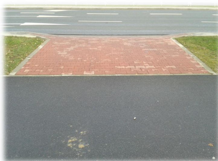
Ryc. 25. Foto.7. Przykład dobrze wykonanego (jezdni – ścieżka) zjazdu z jezdni przez ścieżkę rowerową. Źródło: archiwum M&G.
