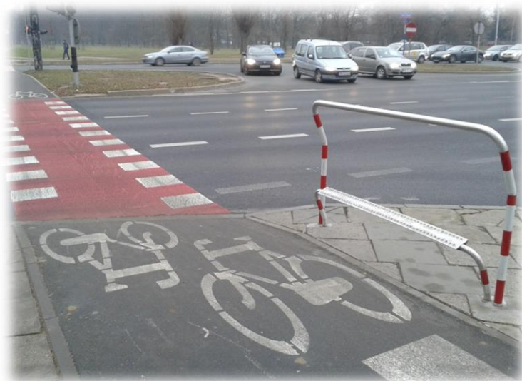
Ryc.82. Foto.38. Podpórka rowerowa przy przejeździe dla rowerów. Źródło: archiwum M&G.
