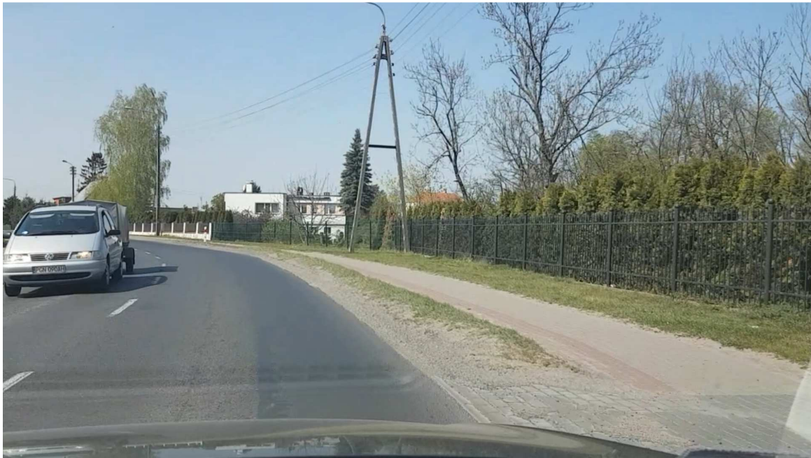
Rys. 6.54 ul. Kłeckoska – stan istniejący
