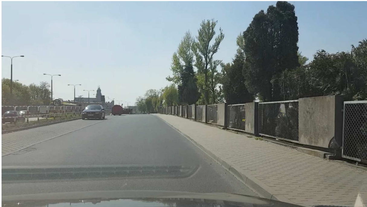
Rys. 6.61 ul. Żuławy – stan istniejący
