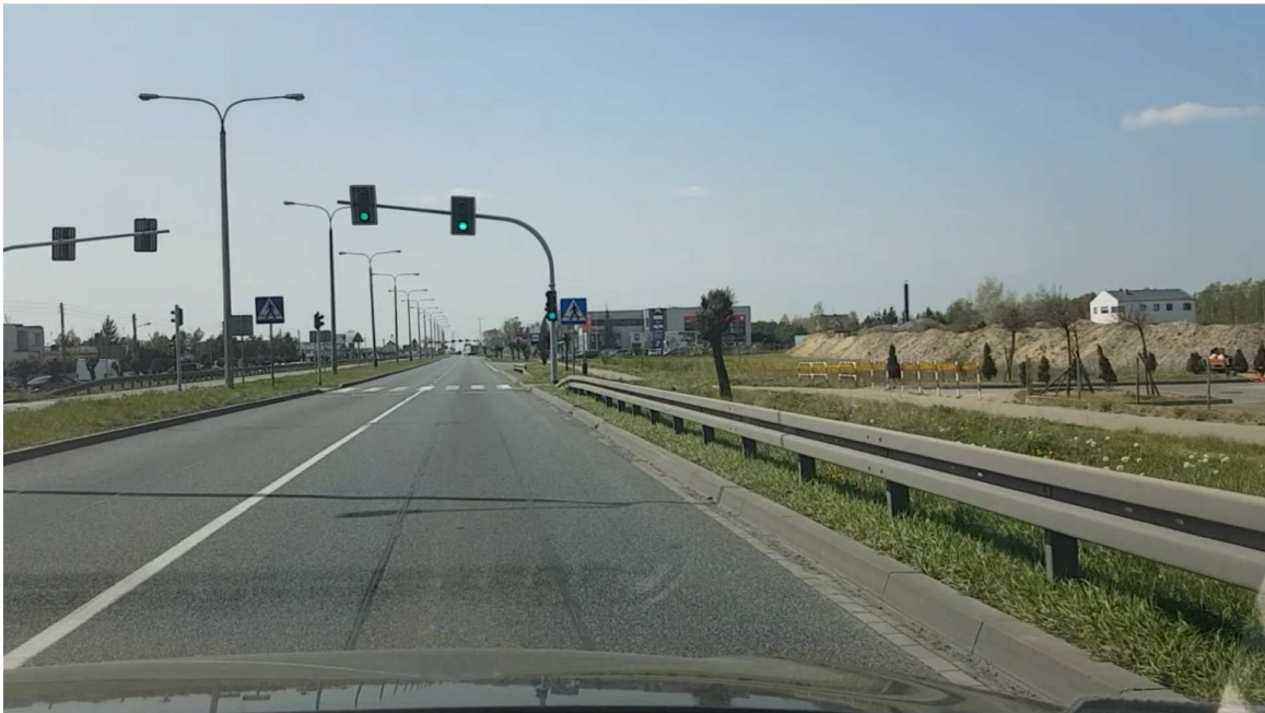
Rys. 6.49 ul. Poznańska – stan istniejący
