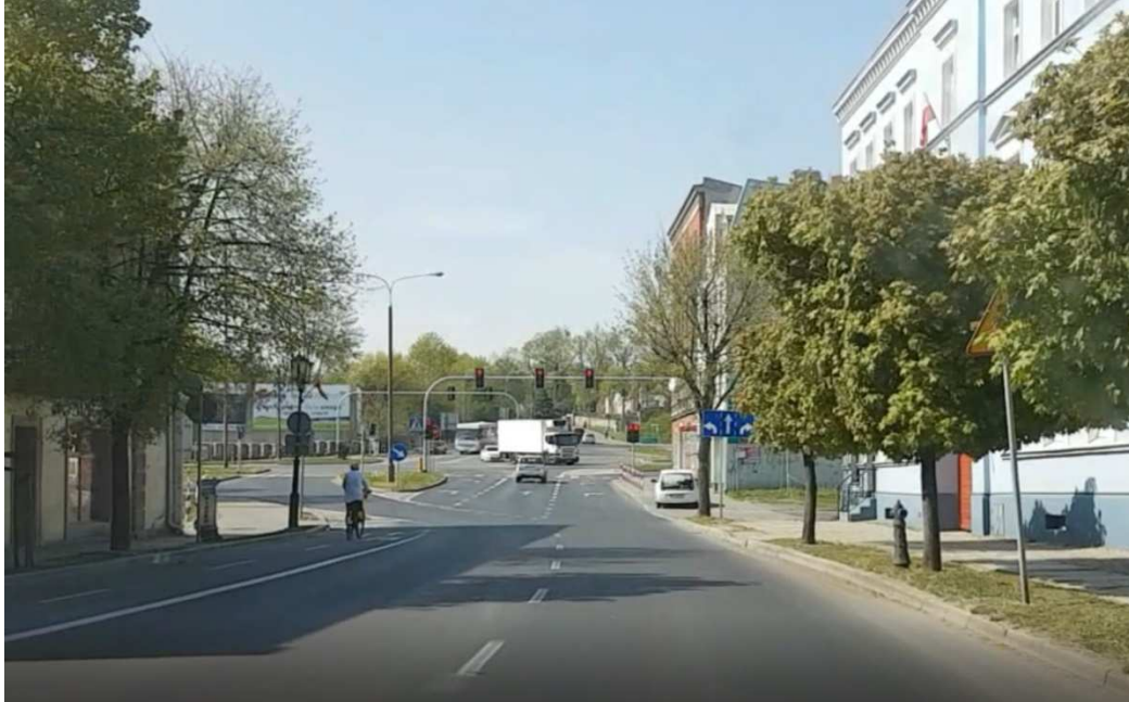
Rys. 4.7 Trasa nr 6 – ul. Łaskiego – stan istniejący
