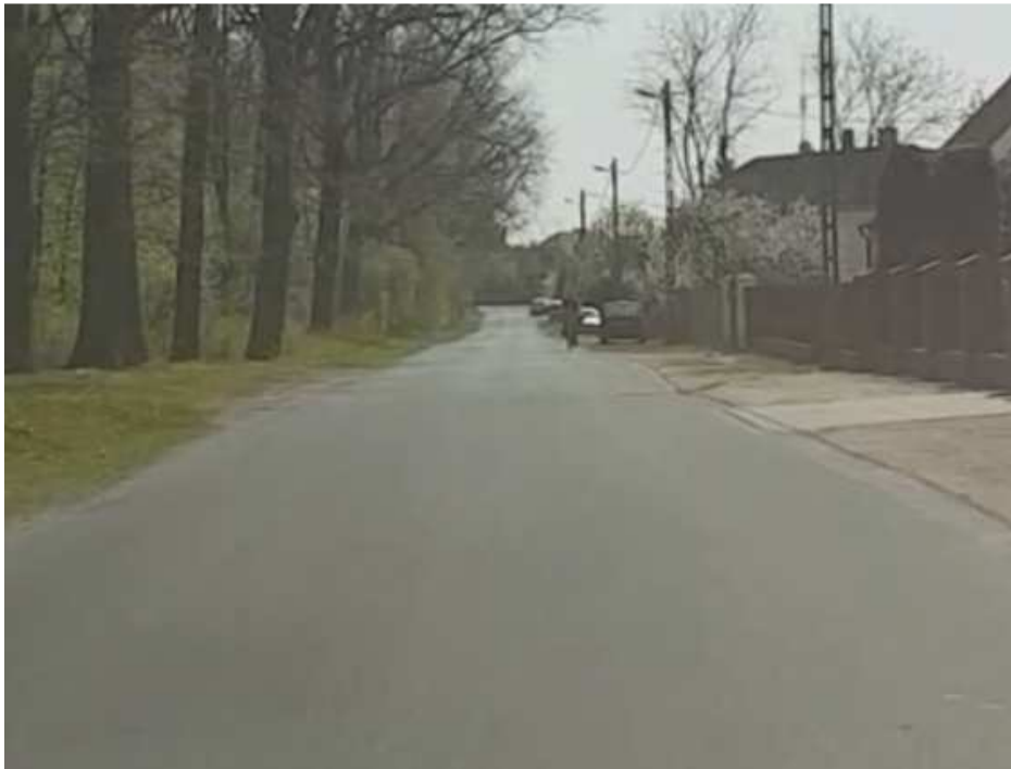
Rys. 6.41 ul. Dębińska– stan istniejący
