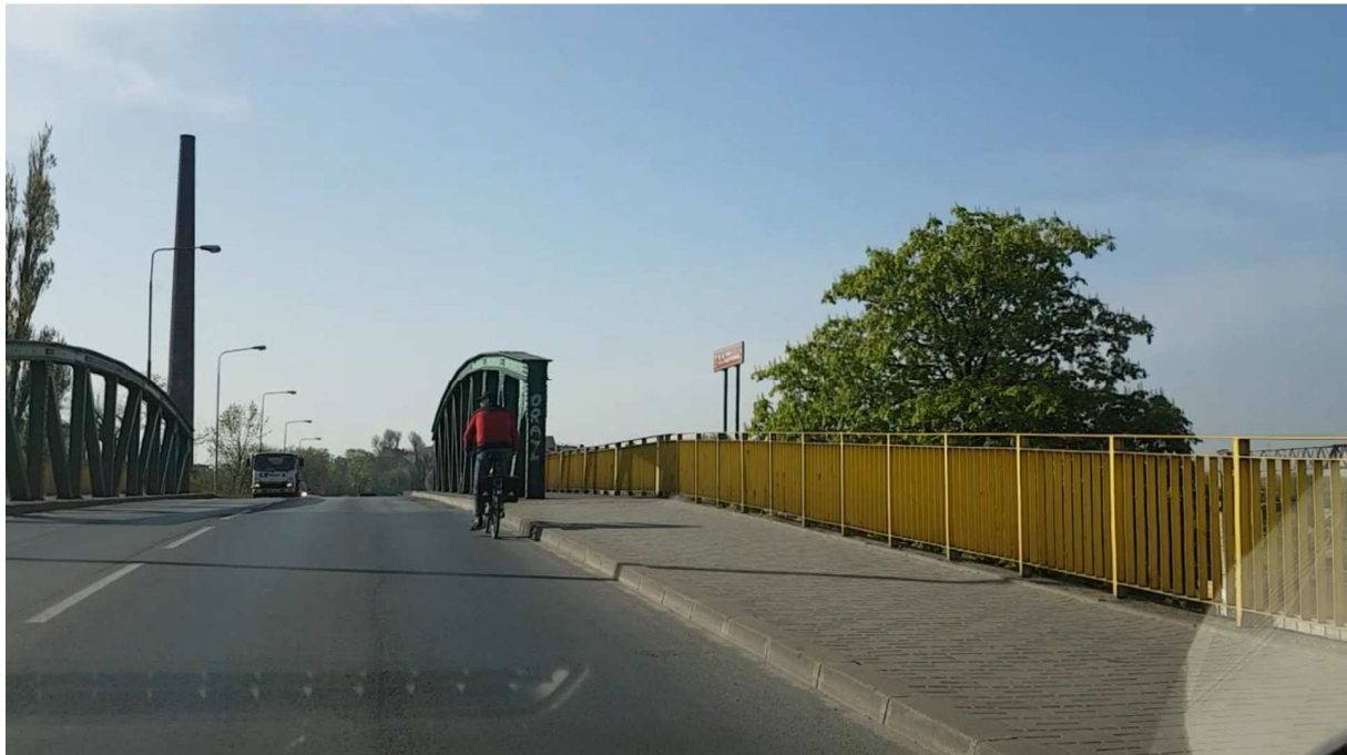
Rys. 6.10 ul. Warszawska – stan istniejący
