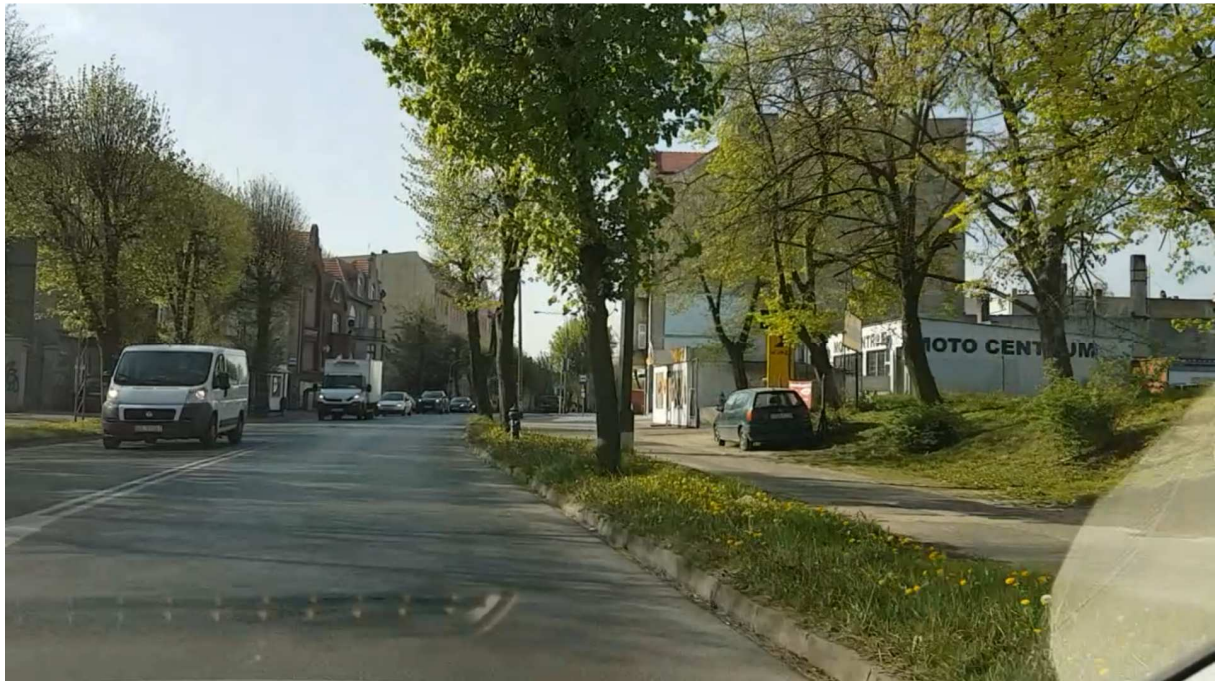
Rys. 6.11 ul. Wrześcińska – stan istniejący
