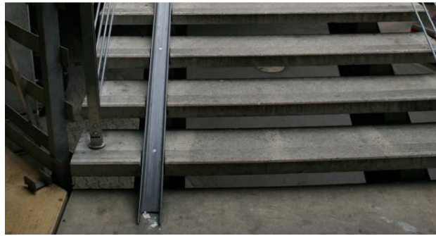
Rys. 3.28 Przykład zastosowania rampy rowerowej na schodach [12]
