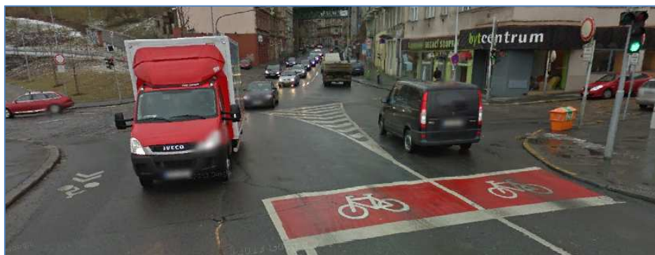
Rys. 3.9 Zastosowanie śluzy typu Ia na ulicy Husitskiej w Pradze
