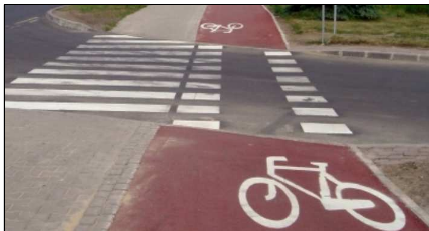
Rys. 3.31 Przykład przejazdu rowerowego przy przejściu dla pieszych
