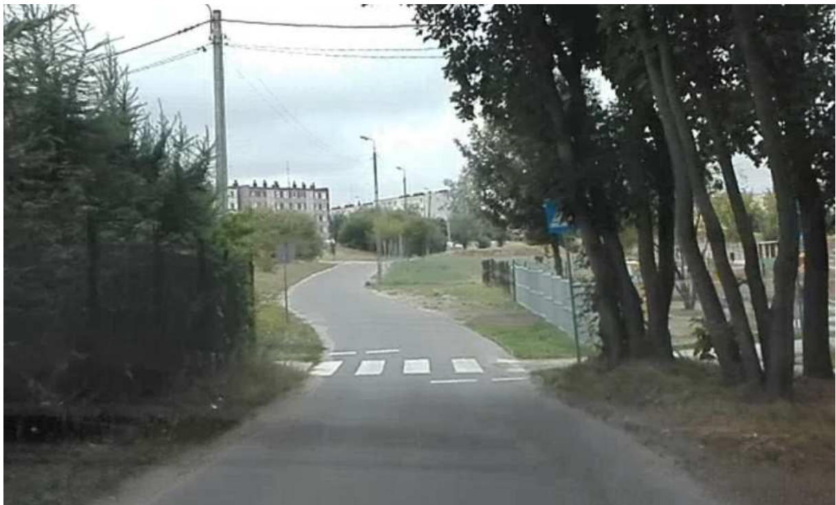
Rys. 6.29 ul. Spokojna – stan istniejący
