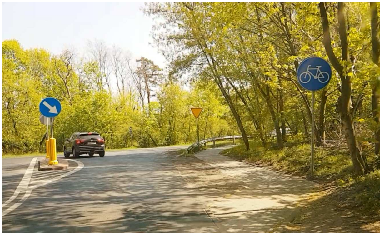
Rys. 4.16 Trasa nr 13 – wjazd w ul. Kostrzewskiego od strony ul. Prostej – stan istniejący
