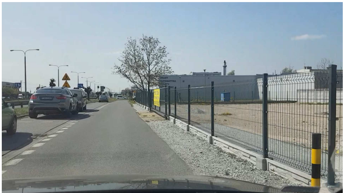
Rys. 6.50 ul. Poznańska – stan istniejący
