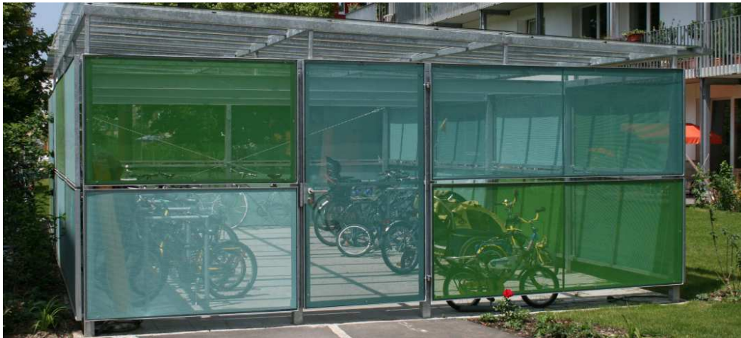
Rys. 3.25 Kryty parking rowerowy, ogrodzony na osiedlu mieszkalnym [12]
