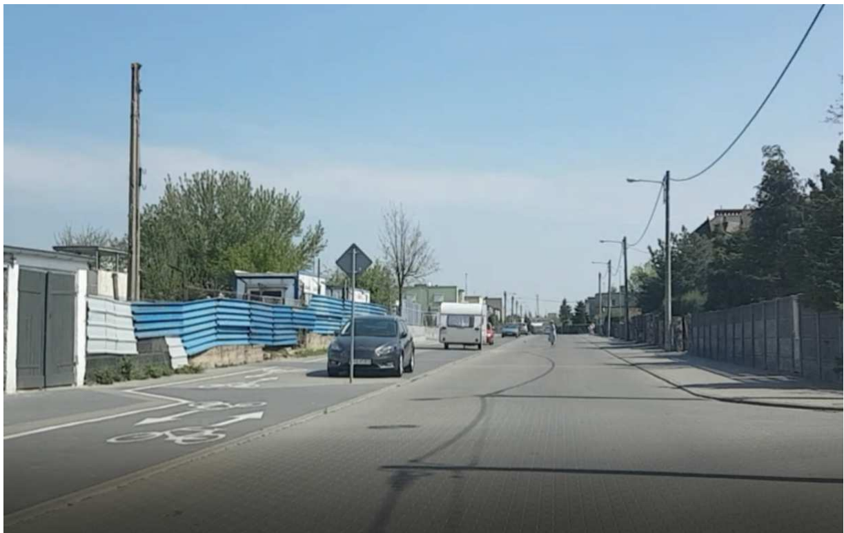
Rys. 4.4 Trasa nr 3 – ul. Roosevelta przy skrzyżowaniu z ul. Reja – stan istniejący
