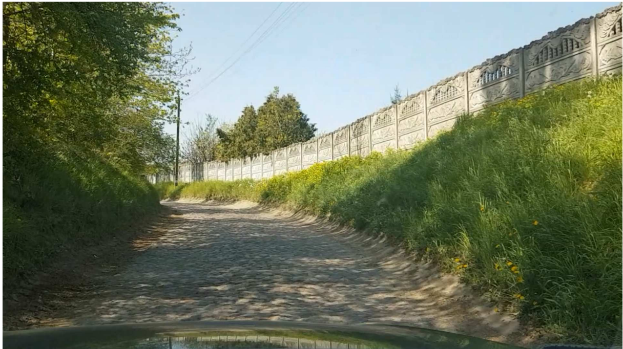
Rys. 6.56 ul. Górna – stan istniejący
