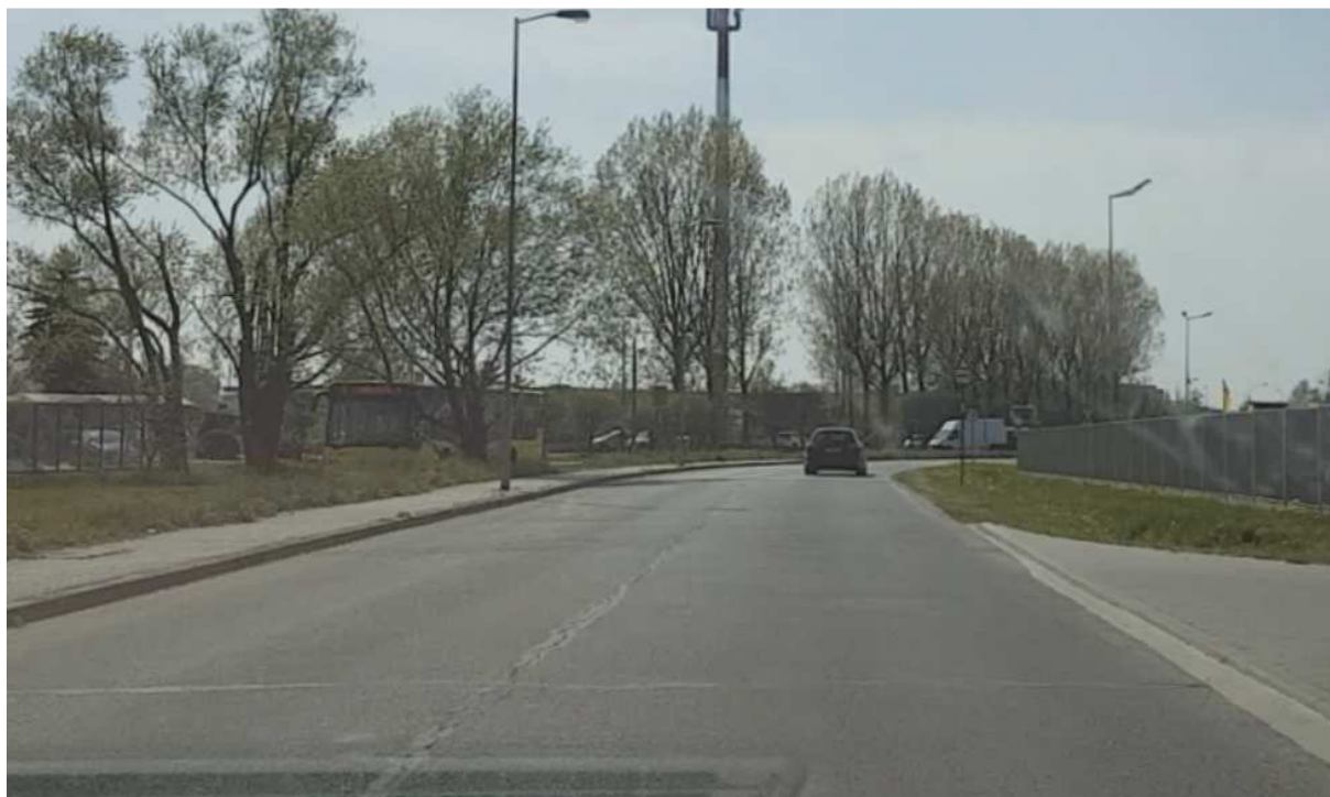
Rys. 6.36 ul. Kolejowa– stan istniejący
