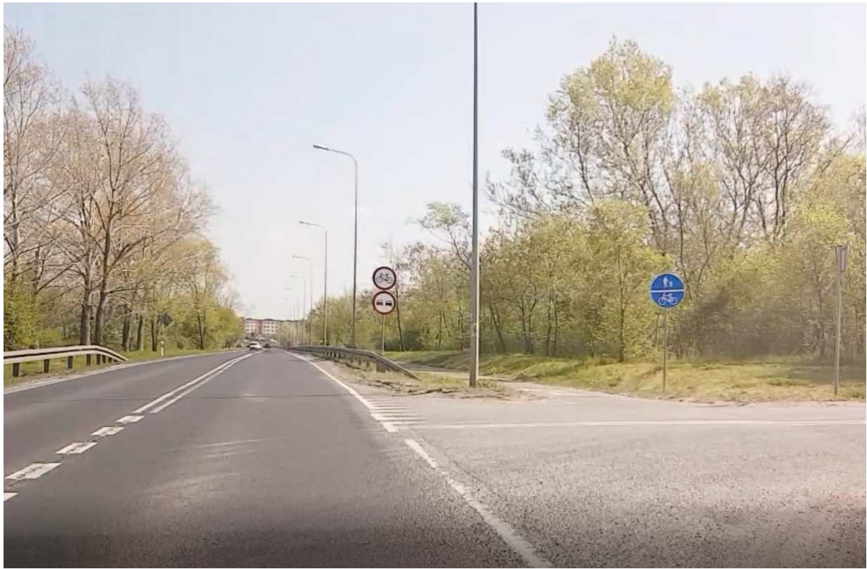
Rys. 4.15 Trasa nr 13 – ul. Kostrzewskiego – stan istniejący
