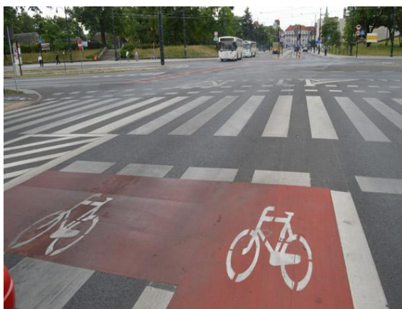
Ryc. 11. Śluza rowerowa oraz przejazd rowerowy przez skrzyżowanie
