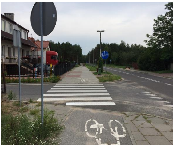
Ryc. 19. Złe przykłady infrastruktury rowerowej - brak przejazdów rowerowych i wysokie krawężniki
