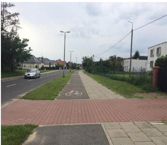
Ryc. 20. Złe przykłady infrastruktury rowerowej - brak ciągłości infrastruktury rowerowej na wyjazdach z posesji
