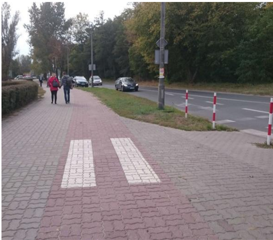
Ryc. 18. Złe przykłady infrastruktury rowerowej - nawierzchnia z kostki brukowej i ze zniszczonych płyt betonowych
