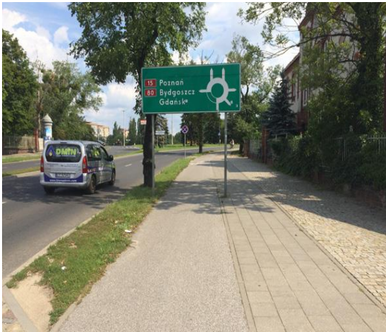
Ryc. 17. Złe przykłady infrastruktury rowerowej - brak skrajni oraz zieleni w skrajni
