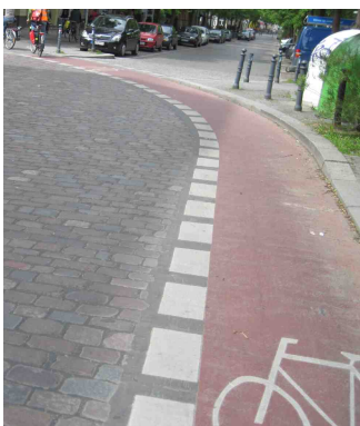
Niemcy, Berlin. Asfaltowy dywanik na brukowanej jezdni.
