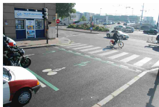
Francja, Nantes. Śluzę dla rowerów (TYP I) wraz ze strzałkami kierunkowymi ułatwiającymi zajęcie odpowiedniej pozycji przez rowerzystę.
