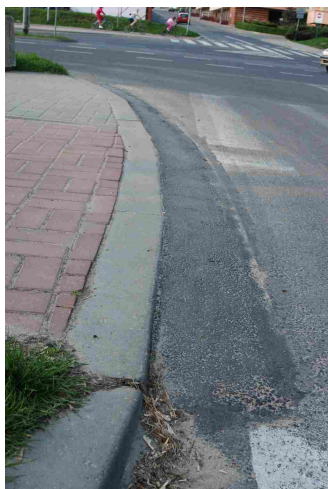
Klin z masy bitumicznej ułatwiający podjazd na krawężnik - rozwiązanie tymczasowe.
