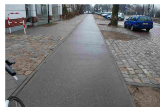
Toruń. Zachowanie ciągłości nawierzchni drogi dla rowerów na przecięciu zjazdu.
