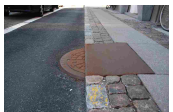
Dania, Kopenhaga. Studzienka pomiędzy obniżoną drogą dla rowerów a chodnikiem.
