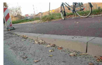
Szczecin. ul. Gdańska. Wjazd na drogę dla rowerów po rampie długości 3,0 m.
