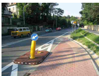
Kraków. Zjazd z drogi dla rowerów na jezdnię za pomocą pasa włączania.
