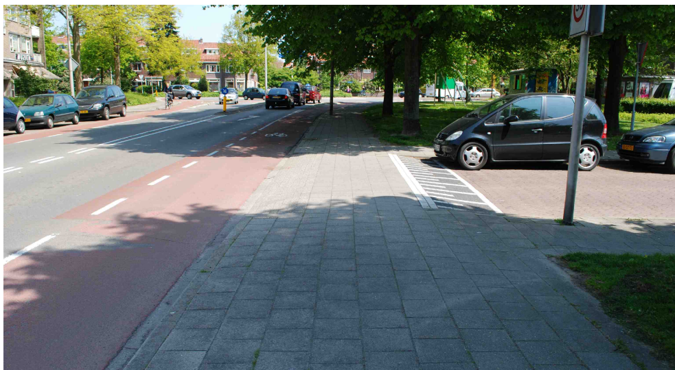
Ilustracja 5.2: Holandia, Zwolle. Efekt "bramy" uzyskany poprzez zachowanie konstrukcji chodnika na zjeździe.
