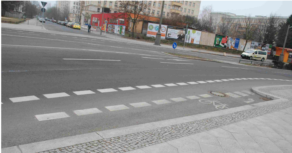
Ilustracja 8.2: Niemcy, Berlin. Śluza dla rowerów ułatwiająca wykonywanie manewru skrętu w lewo.
