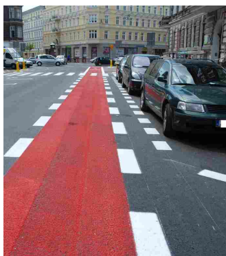
Szczecin, Kontrapas przy ul. Rayskiego.
