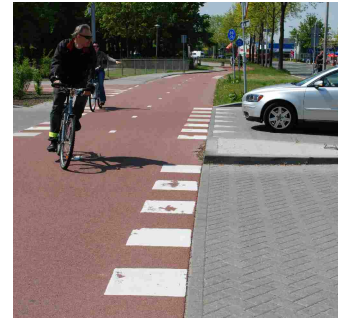
Holandia, Zwolle. Droga dla rowerów odsunięta od jezdni kilkadziesiąt metrów przed przejazdem dla rowerzystów.
