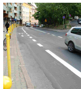
Szczecin, ul. Piotra Skargi. Pas ruchu dla rowerów po jednej stronie ulicy ze spadkiem podłużnym.
