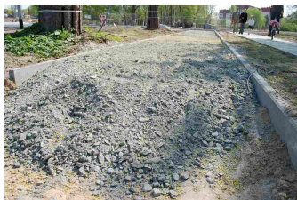
Szczecin. Podbudowa pod nawierzchnię bitumiczną drogi dla rowerów.
