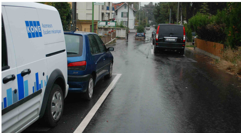
Ilustracja 5.3: Szwajcaria, Genewa. Załamanie osi jezdni poprzez niesymetrycznie wyznaczone miejsca postojowe.
