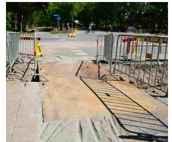
Turku, Finlandia. Tymczasowa nawierzchnia z płyty stalowej.
