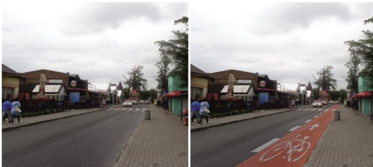
Ryc. 61 Przykładowa zmiana organizacji istniejącego układu drogowego - pas rowerowy w obrębie jezdni (Typ 1a)
