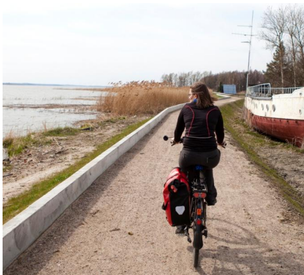
Ryc. 7, 8 Drogi z nawierzchni tłuczniowej
