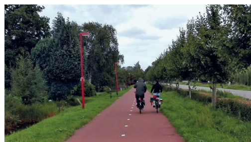
ZDJĘCIE 62. Holandia, Utrecht. Oświetlenie drogi dla rowerów.
