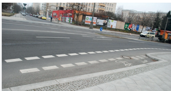
ZDJĘCIE 36. Niemcy, Berlin. Śluz dla rowerów ułatwiająca wykonywanie manewru skrętu w lewo.
