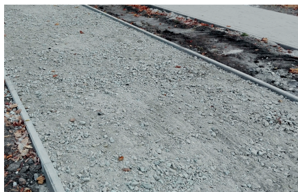
ZDJĘCIE 18. Wrocław. Podbudowa drogi dla rowerów.
