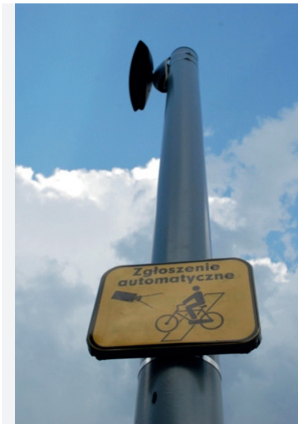
ZDJĘCIE 49. Łódź. Detekcja optyczna przed przejazdem dla rowerzystów.
