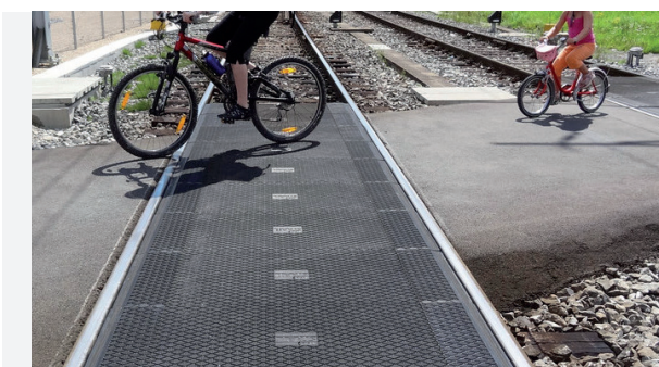
ZDJĘCIE 43. Bezrowkowy przejazd rowerowy przez linię kolejową:
