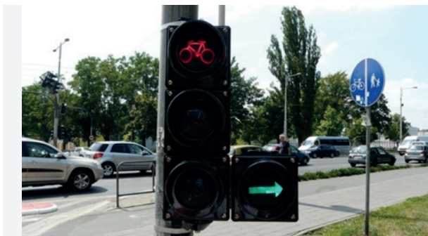
ZDJĘCIE 48. Polska, Wrocław. Sygnalizator S-1a z możliwością warunkowego skrętu w prawo.
