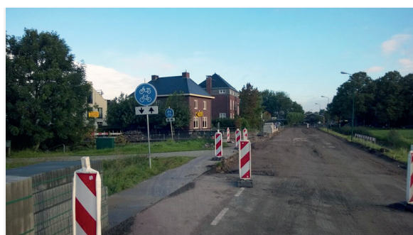
ZDJĘCIE 74. Tymczasowa nawierzchnia drogi dla rowerów z płyt stalowych.
