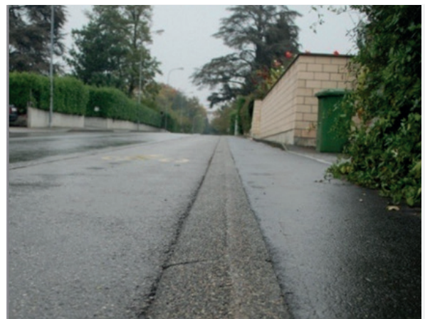
ZDJĘCIE 16. Szwajcaria, Genewa. Droga dla rowerów obniżona względem chodnika.
