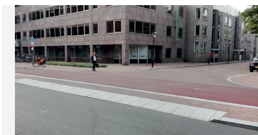
ZDJĘCIE 38. Holandia, Utrecht. Droga dla rowerów oraz chodnik przez wlot drogi podporządkowanej.
