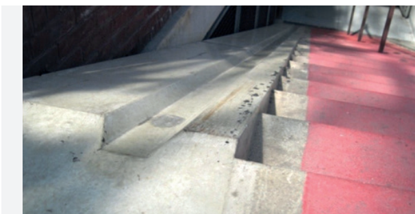
ZDJĘCIE 58. Holandia, Zwolle. Rampa do wprowadzania rowerów.
